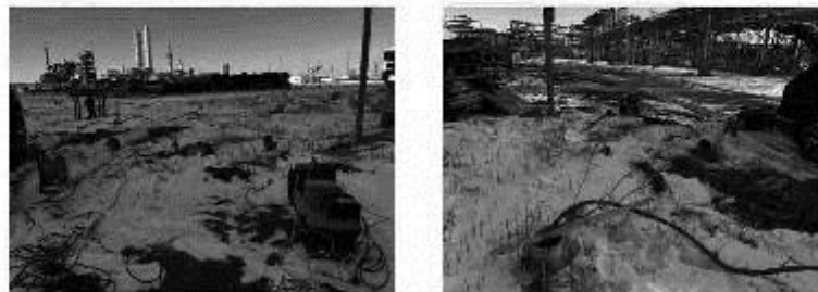
抽水试验现场
