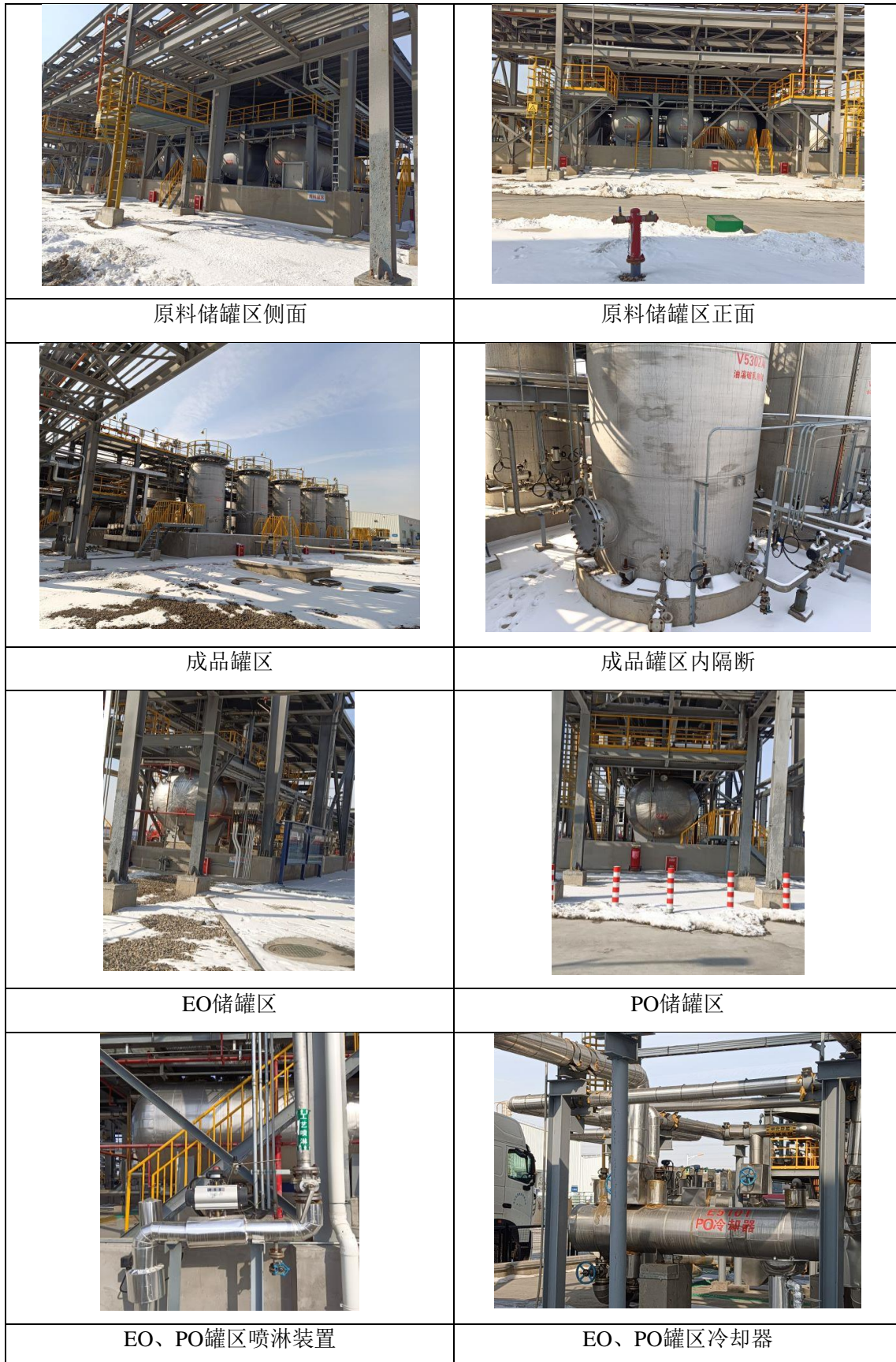
图 3.2-1 罐区现状照片
