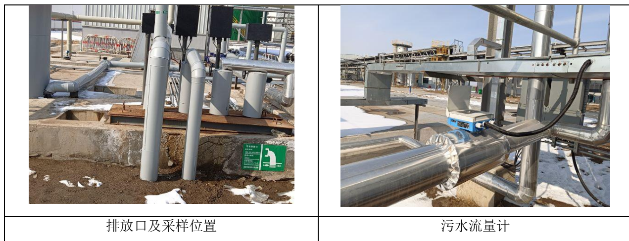
图 4.1-2 污水处理站现场照片
