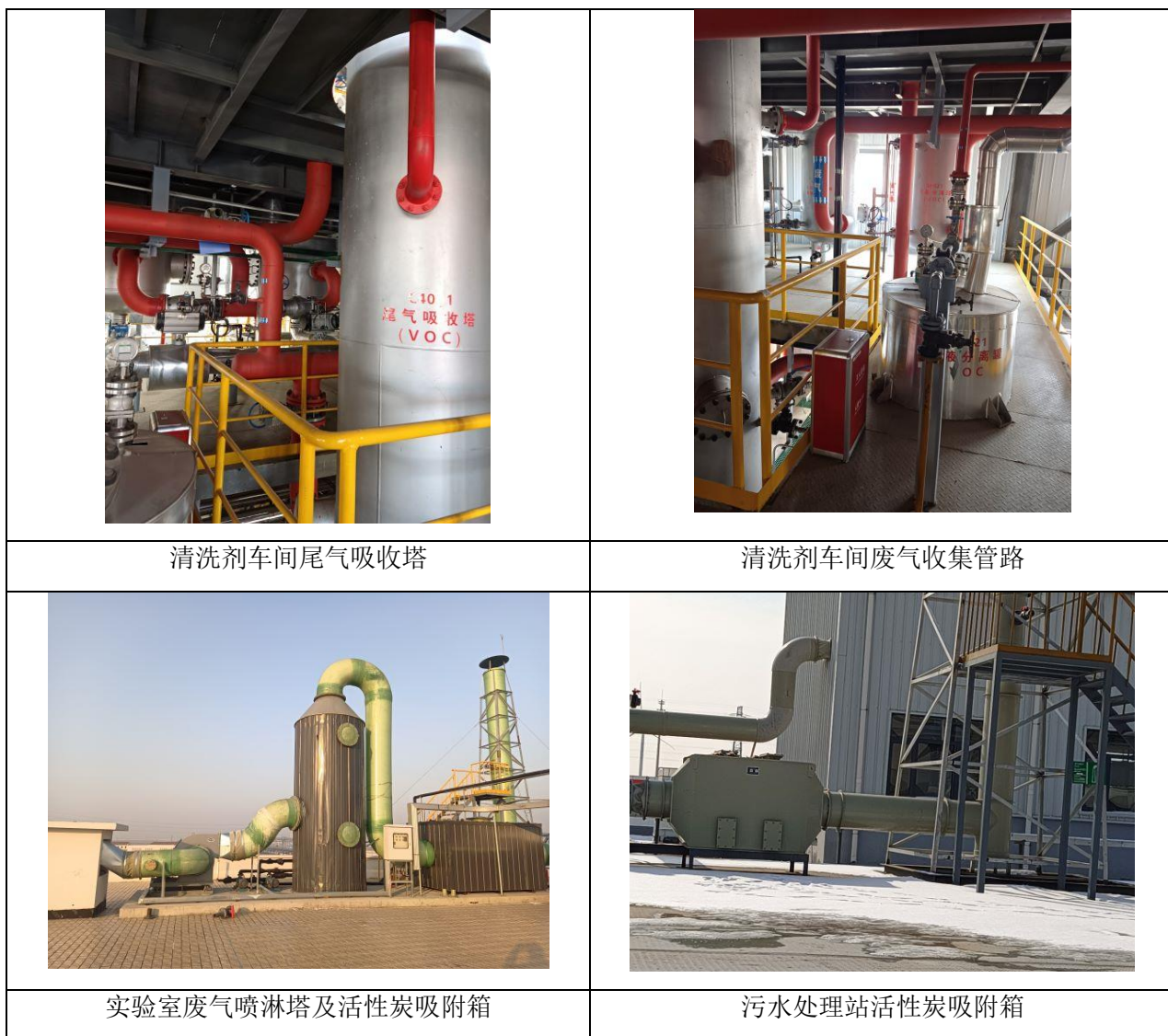
图 4.1-4 废气处理措施照片
