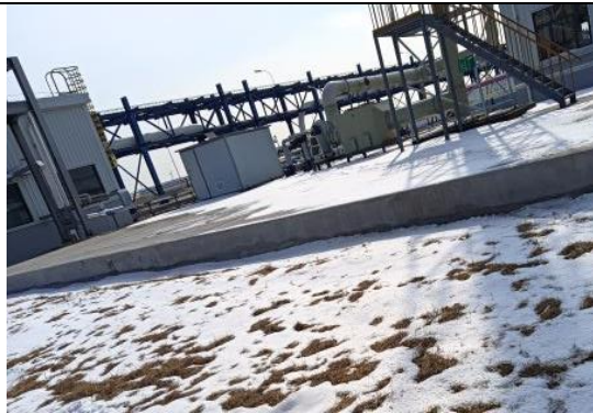
污水处理站地面情况
