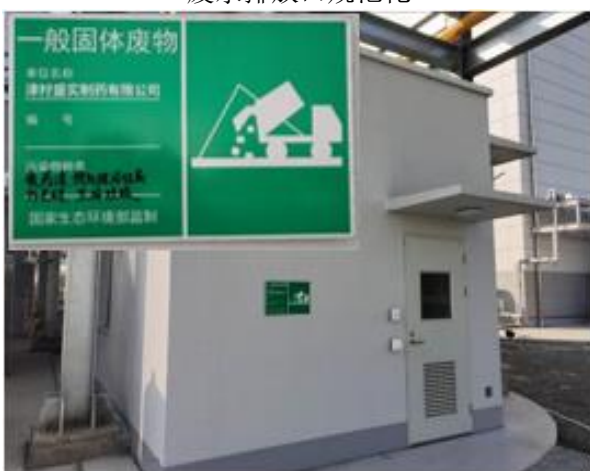
一般固废暂存间规范化
