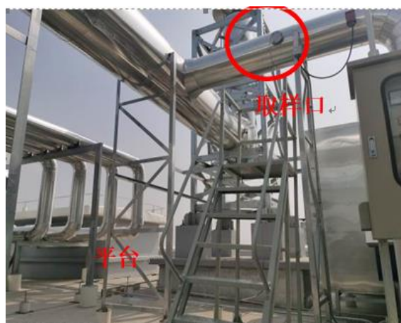
DA001采样口及监测平台
