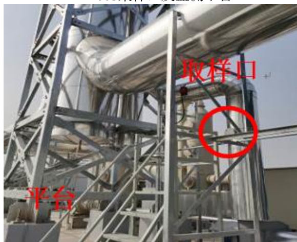
DA006采样口及监测平台
