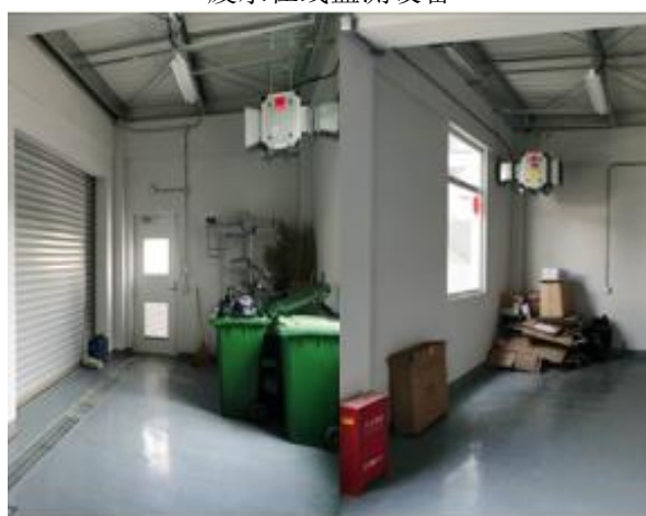
一般固废暂存间内部
