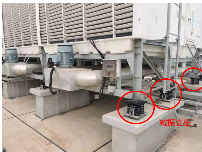
图 4.1-4 噪声治理措施照片
