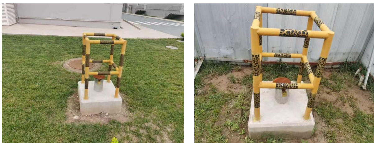
图 4.2-3 地下水永久监测井
