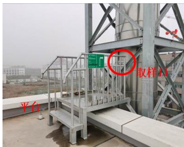
DA007采样口及监测平台
