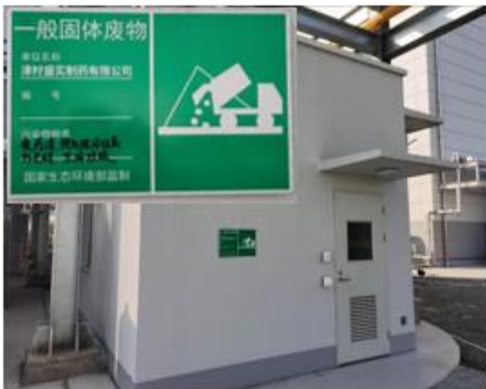
图 4.1-5 一般固体废物暂存间外部照片
