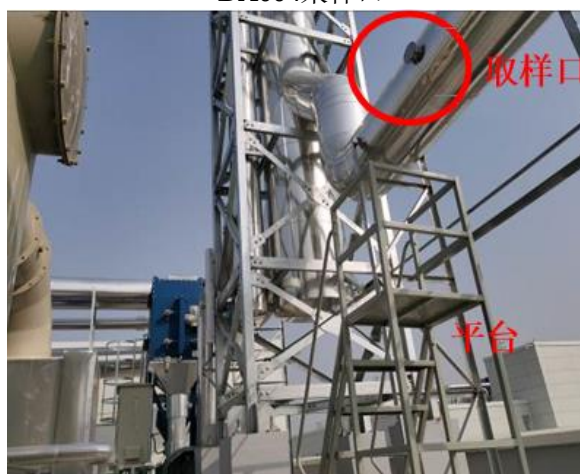
DA005采样口及监测平台
