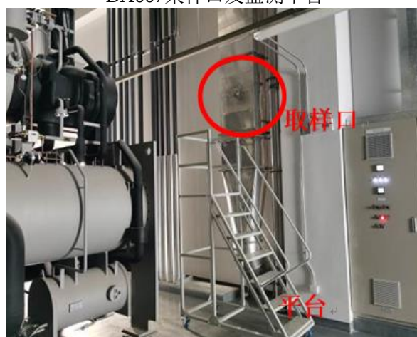
DA008采样口及监测平台
